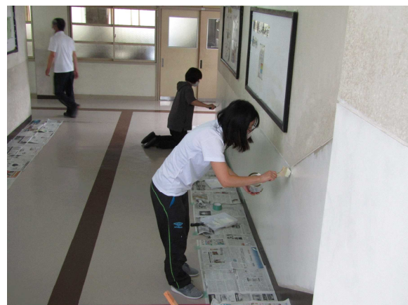
校舎内の壁面のペンキ塗り
